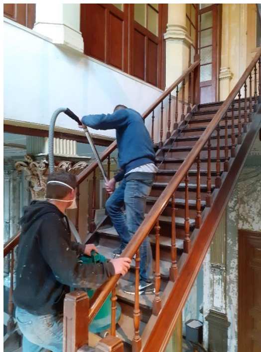
Opruimwerken en renovatie in De Lovie in Poperinge
