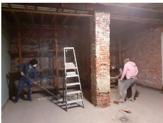
Opruimwerken in De Lovie Poperinge
