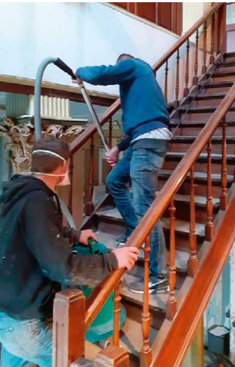
Opruimwerken en renovatie in De Lovie in Poperinge.
